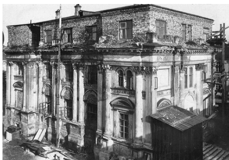
Перестройка здания Марии Магдалининской церкви под учебное заведение. 1934 г. ГАПО. Ф.р-1706. Оп. 1. Д. 334.
