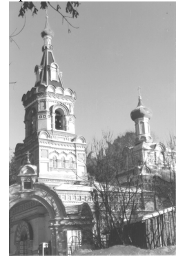
Успенская церковь. 1999 г. Из новых поступлений.
